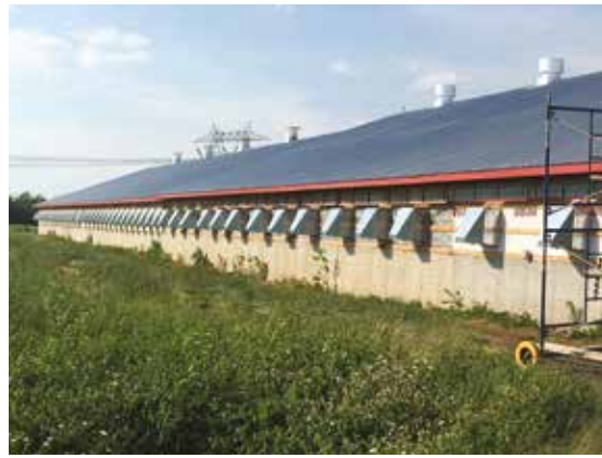
Après les modifications : ventilateur et filtre qui font entrer l'air dans le bâtiment
